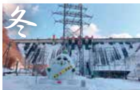
津軽の水がめ『浅瀬石川ダム』
